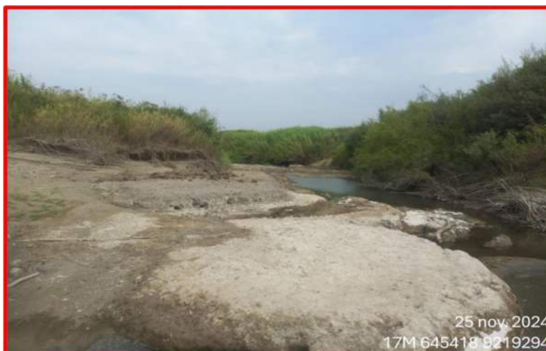
FIGURA N°0: Cauce colmatado de sedimentos en el río Zaña, sector Peroles, Progresiva: 0+150,00
