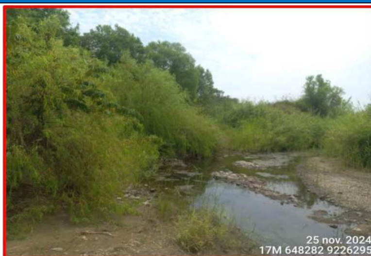
FIGURA N° 01: Cauce estrecho y colmatado de sedimentos y vegetación del río Zaña, sector Pueblo Libre. Progresiva: 0+005,00
